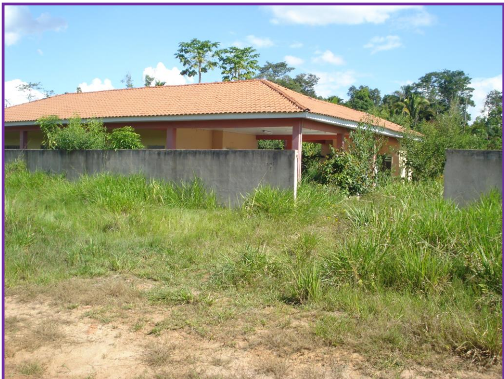
Figura 13: Escola fechada na Linha 17, Assentamento Joana D'Arc III (FERREIRA, 2013).
