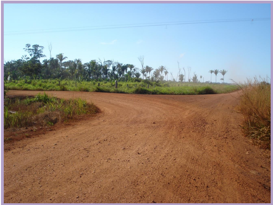
Figura 01: Estrada do Assentamento Joana D'Arc III. Porto Velho/RO. (FERREIRA, 2013).
